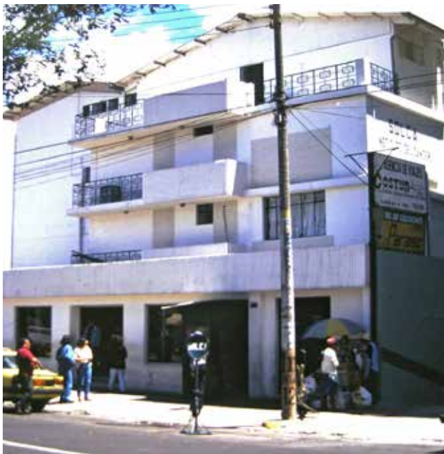
Solca cuando funcionaba en la Av. de Los Shyris, 1981
